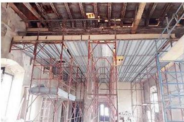
Ponteggi... fra generazioni. I lavori da poco iniziati a Pademello
