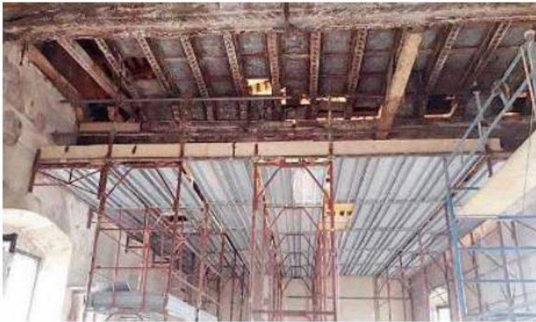
Impalcatura. Lavori in corso nel castello di Padernello
