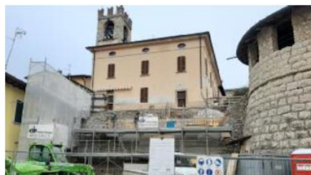
Nel corso dei lavori sono affiorati i resti di un'antica fortificazione
