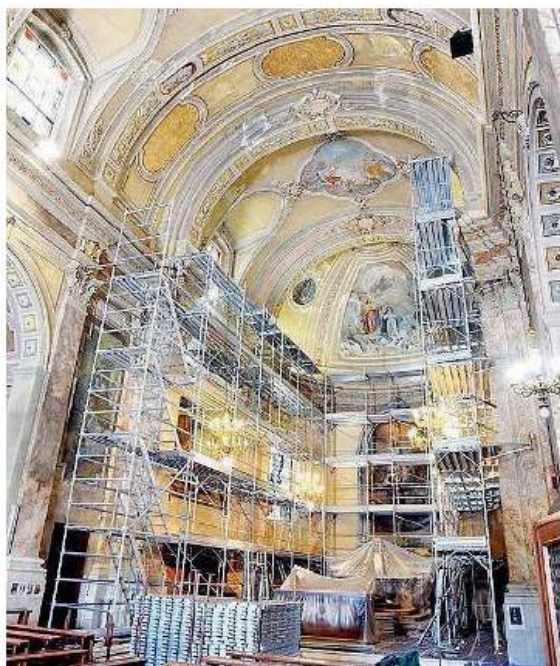
Il cantiere. Già predisposte le impalcature all'interno della chiesa
