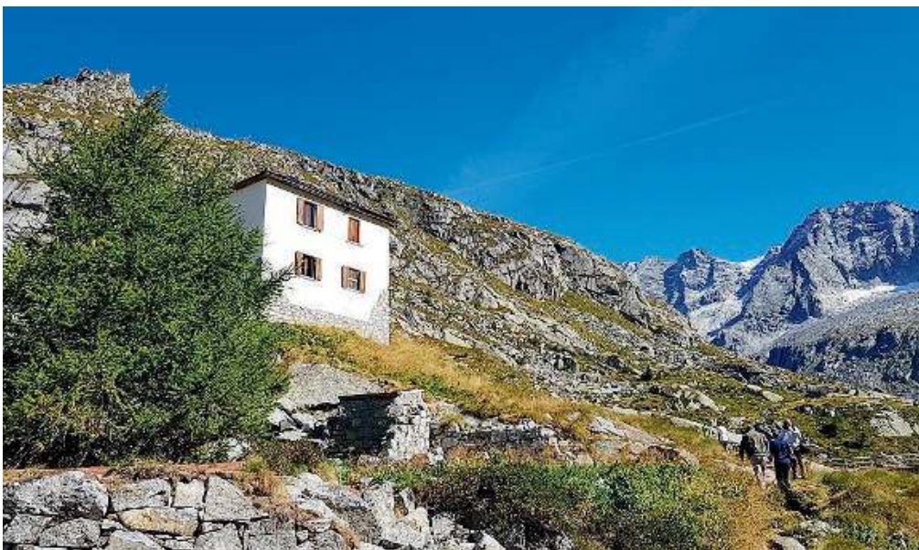
Sopra quota 2mila metri. Il rifugio Gnutti è ora dotato di un impianto di fitodepurazione
