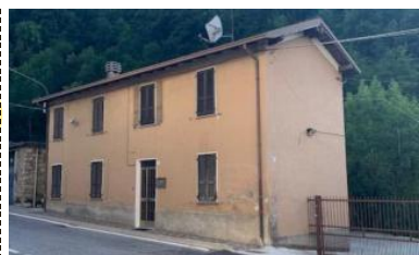
L'edificio a Lumezzane che ospita l'appartamento dedicato
