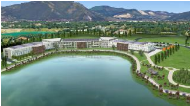
La struttura della Rsa affaccia sul laghetto della ex cava Faustini
