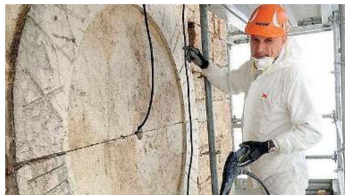
La scoperta. Il quadrante rimasto a lungo «nascosto» dall'intonaco
