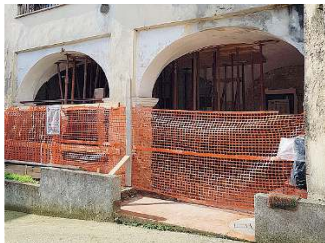
In via Sant'Emiliano. La struttura che ospiterà i due appartamenti
