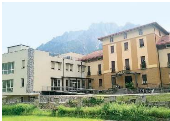
Via Marconi 3. La struttura della casa di riposo ampliata e rinnovata
