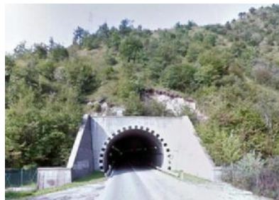
Da Agnosine verso Lumezzane l'imbocco di una delle tre gallerie
