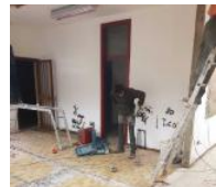
Lavori per la cucina didattica
