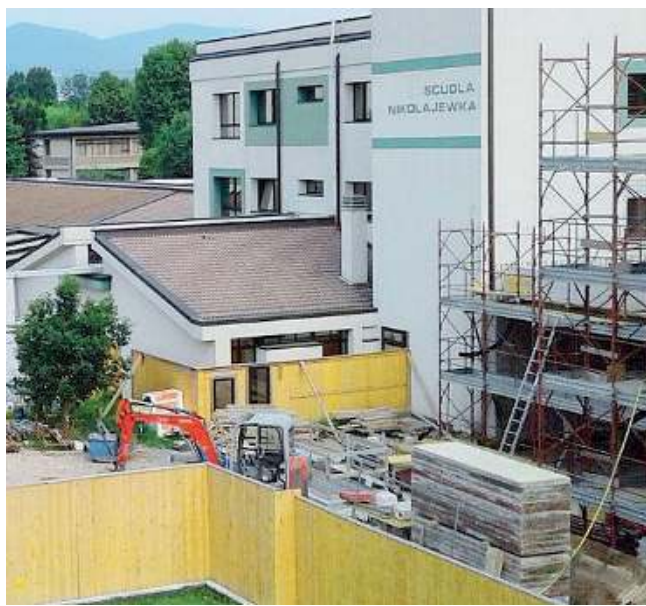
Il cantiere. A Mompiano, le impalcature accanto alla sede storica
