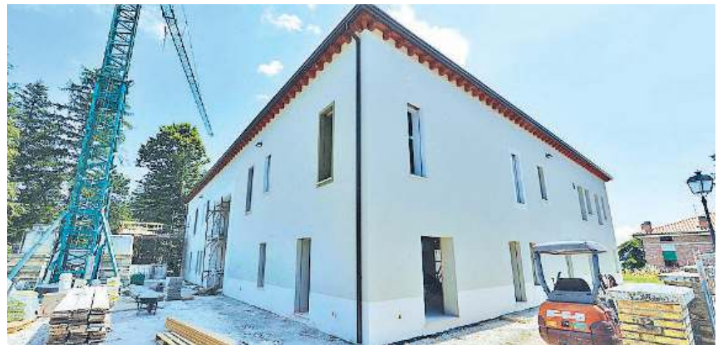
Avanzamento lavori. La scuola di Gualdo sarà pronta per l'inizio del prossimo anno scolastico // NEG STRADA
