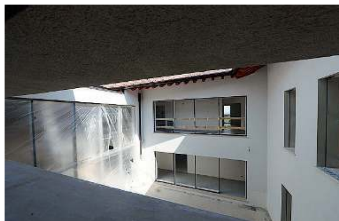
Cortile interno. Come si presenta oggi la futura scuola
