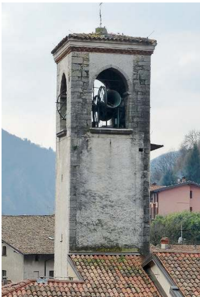
Verso i lavori. L'intervento dovrebbe partire verso la fine di giugno
