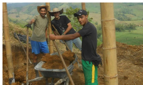
Alcuni dei volontari impegnati nei lavori per la fattoria didattica
