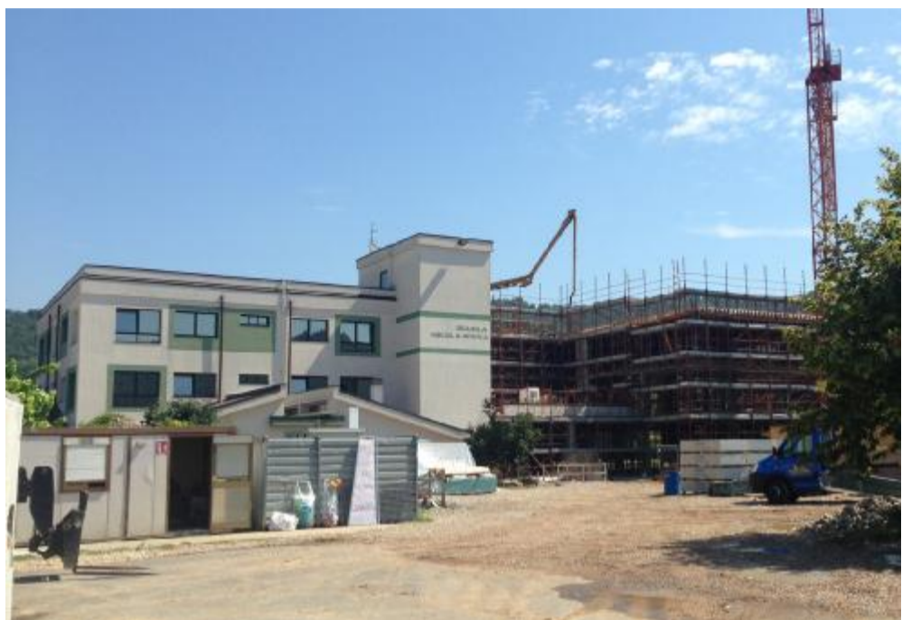
Lavori in corso a Mompiano per la costruzione del nuovo padiglione della «Scuola Nikolajewka»
