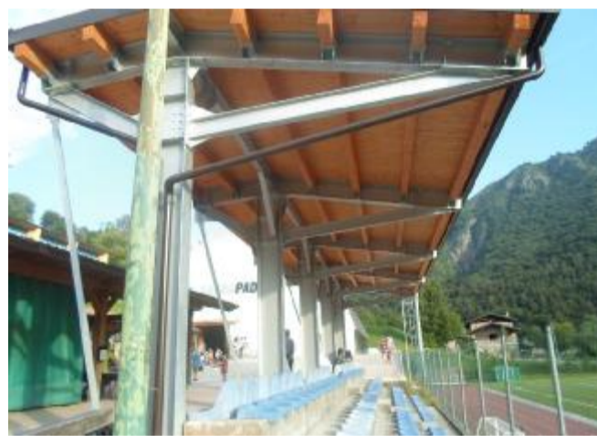
La nuova copertura in legno della tribuna del campo da calcio
