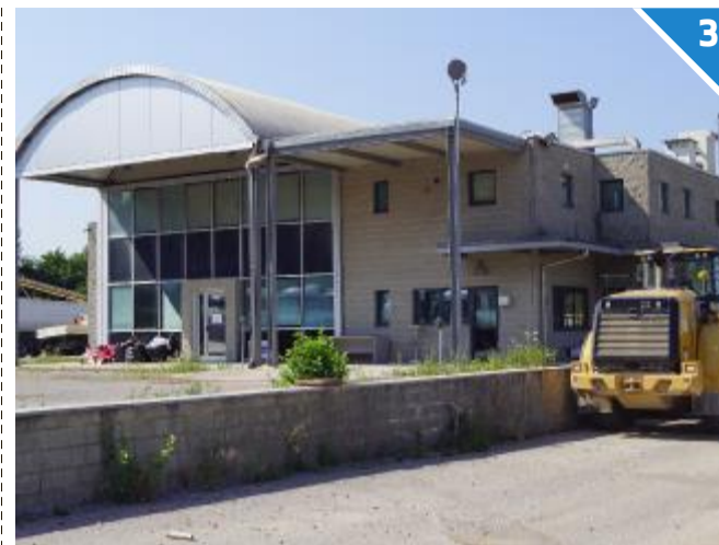
PRESTO UNA RSA. Accanto al laghetto tra via Bose e via Dei Santi sorge una Rsa del gruppo Zaffiro. Ad oggi la zona è ancora ingombra da mezzi e camion di Profacta.
