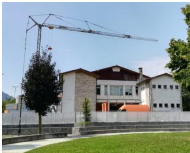
Lavori avviati sull'ex scuola di Lumezzane Faidana
