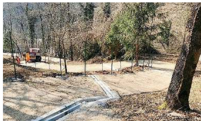
Il cantiere. Procedono i lavori lungo il percorso della ciclabile
