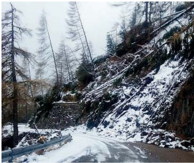
Alberi e massi. Ancora incombono sulla strada che è stata riaperta ieri
