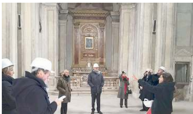
Gli interni. Nella primavera 2019 al via i lavori all'interno della chiesa
