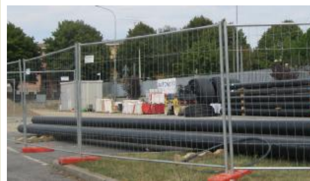
Gli scavi per la posa delle tubature prenderanno il via domani
