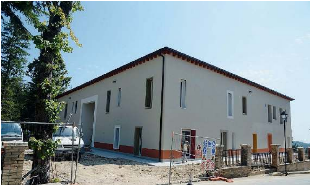
La nuova scuola. L'edificio realizzato dai bresciani con i sottoscrittori dell'iniziativa «Non lasciamoli soli»// NEG
